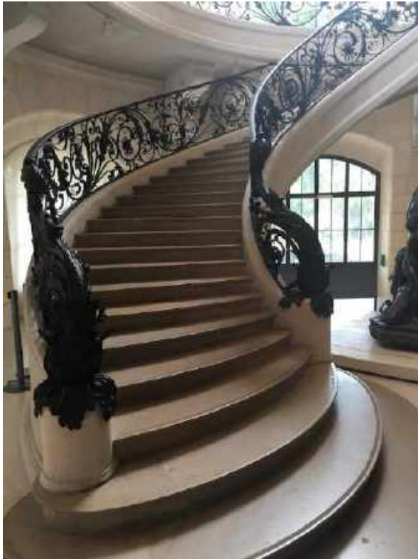
François Hennebique, 1900, concrete stairway in the Petit Palais, Paris.
